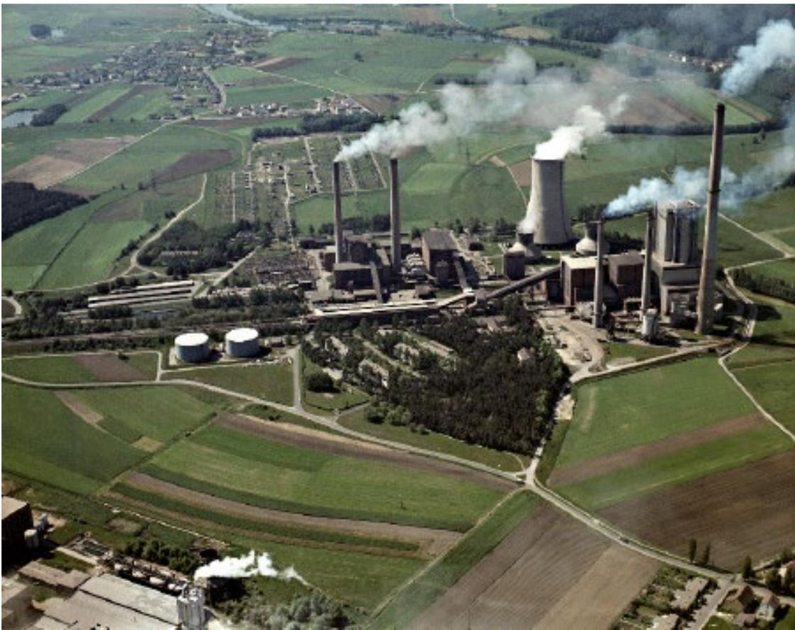
Braunkohlekraftwerk in Dachelhofen, 1972 voll ausgebaut mit 893 MVA / 703MW.
